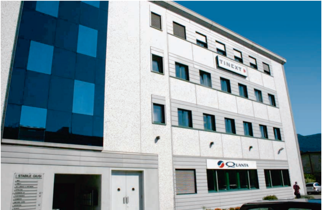
Das BLVK-Notstandsnetz und der künftige Standort: Ein modernes Sicherheitsgebäude mit Top-Infrastruktur im Tessin.
